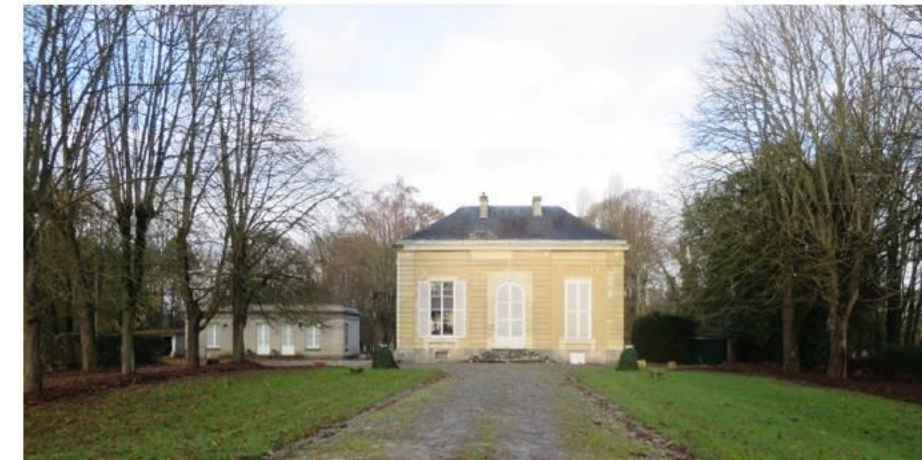
Figure 30 : Vue depuis l'entrée du pavillon du Roi
