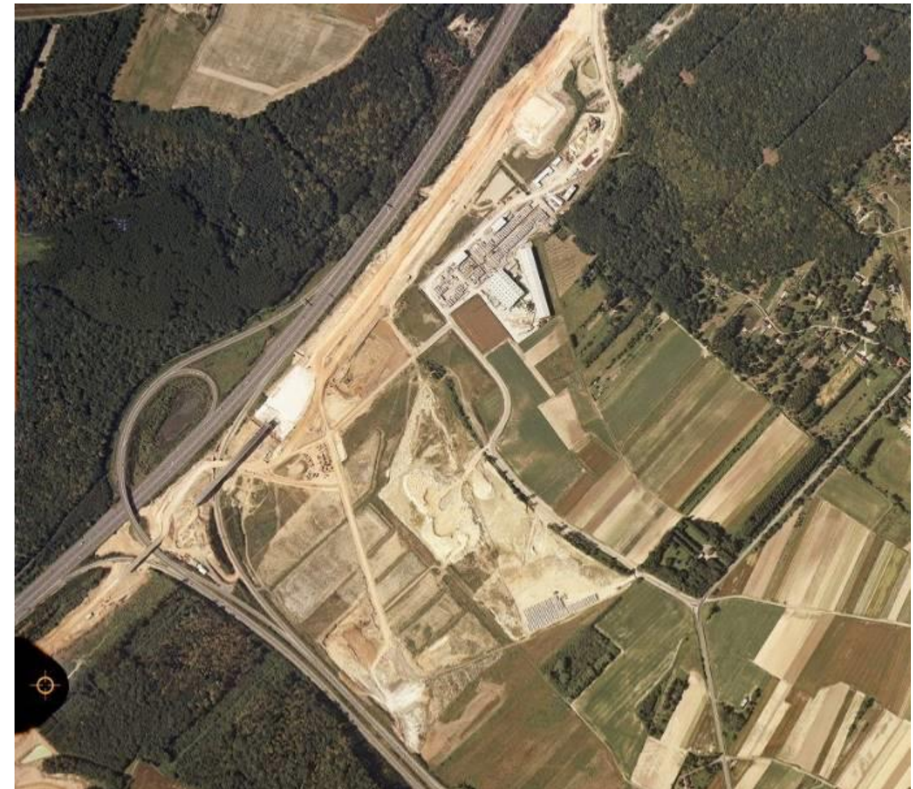
Figure 3 : La construction de ligne TGV atlantique en 1987
